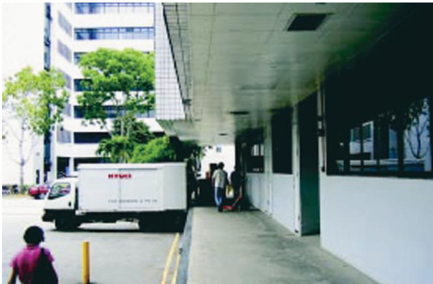
Áreas de carga e descarga bem mantidas e visíveis minimizam as oportunidades da existência de locais propícios para atos ilícitos que beneficiam das características de um edificado com locais para esconderijos
