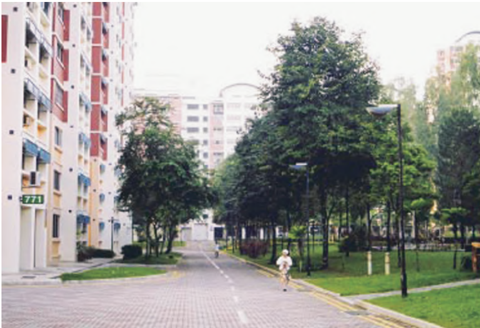
Zona residencial com janelas viradas para parques de estacionamento ou para zonas verdes permitindo uma desimpedida observação do espaço
