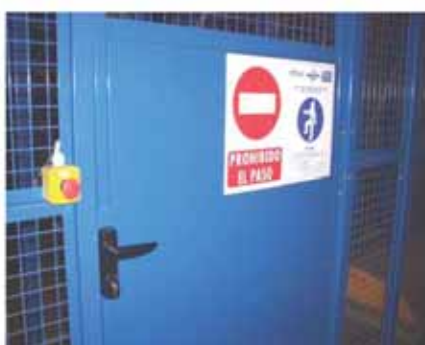
Puerta de acceso a un transelevador
