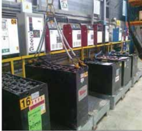
Sala de carga abierta de carretillas elevadoras
