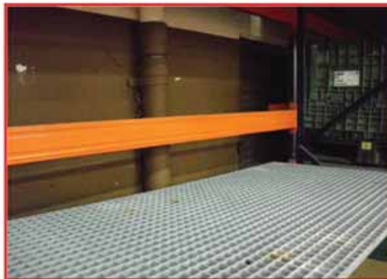
Base portante tipo tramex en la estantería
